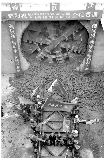
地铁隧道贯通现场
