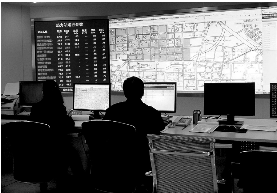
正弘旗二期热力交换站,工作人员实时监控温度
