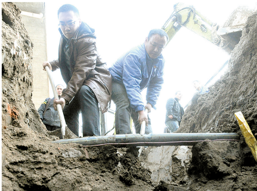
昨日下午,施工人员正在现场紧张维修破损管道。
