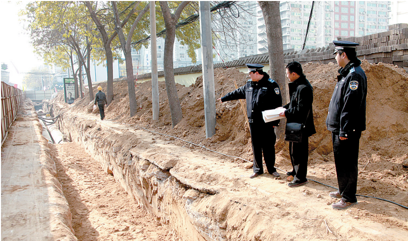
执法人员正在向破路施工方了解施工情况。晚报记者 白韬 图
