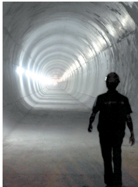
郑州地铁1号线郑州大学站—中原东路站隧道内部景象。(资料图片)
