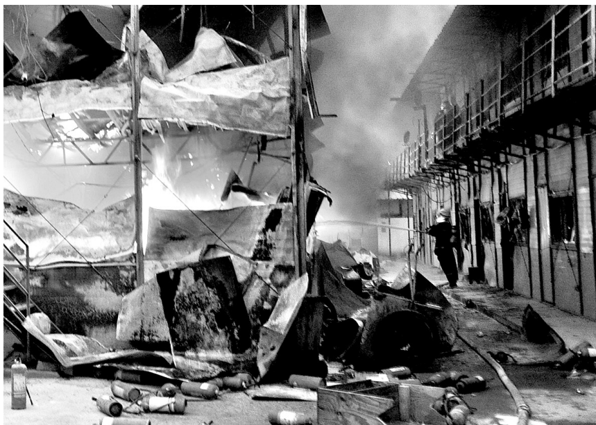
民工宿舍楼烧塌了。
