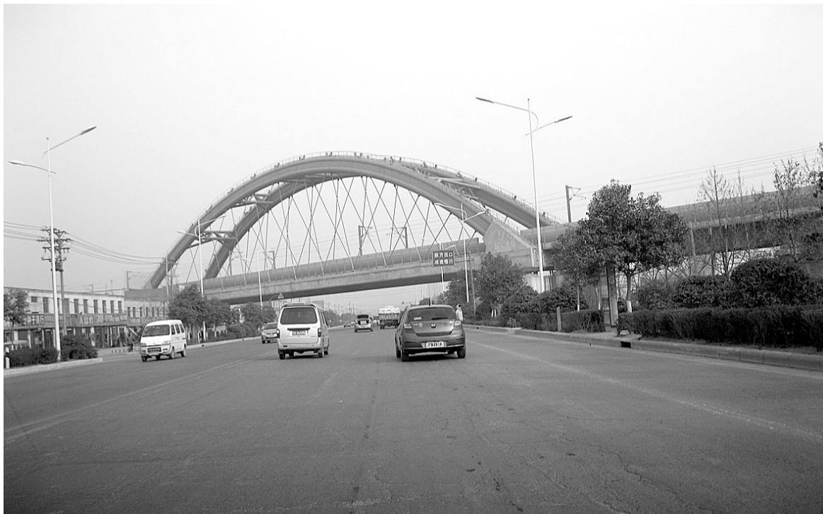
须水街道办事处辖区内整洁的桥梁
