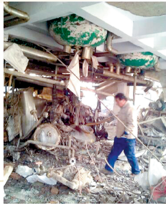
爆炸事故现场内部情况
