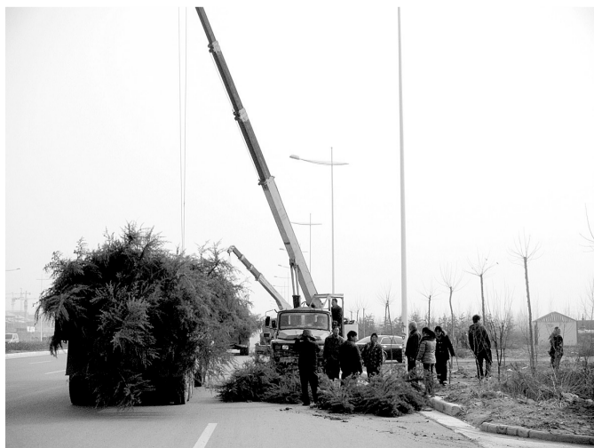
交通道路、生态廊道建设 第一现场
