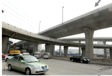
农业路口,工人正在做桥梁伸缩缝的破除和安装,还有一些声屏障安装的扫尾工作。 工作人员说:“应该很快就要通车了,按照现在的施工进度,大概20天就差不多了。”
