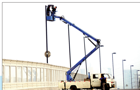
桥上正在安装照明设施。
