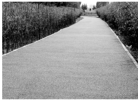
采用透水混凝土的自行车道,用水管浇也积不了水。
