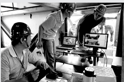
在楼体内部,电脑操控平移进程。
