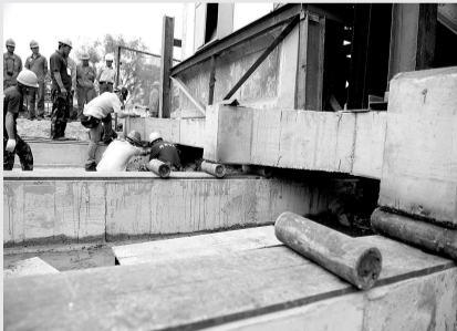
楼体平移的轨道间填入钢滚轴。
