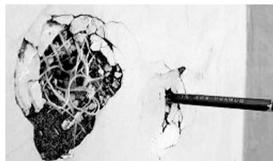
广西南宁市北湖小学一栋新建教学楼刚投入使用不到一年半,外墙上就出现成片的凹坑。有网友称,“墙如蛋壳,一敲就破”。网帖一张图片显示,一支铅笔插入墙体,看起来触目惊心。
