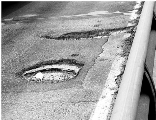
走了一遍，从大桥北端一直到大桥南端，细数桥面大小不一的坑洞，竟然多达117个。而细看这些坑洞的分布，主要在南北两处的上下桥处的坡道上较为密集，隔两米就有三四个坑。只有在南北堡间的正桥上，坑洞才比较稀疏。
