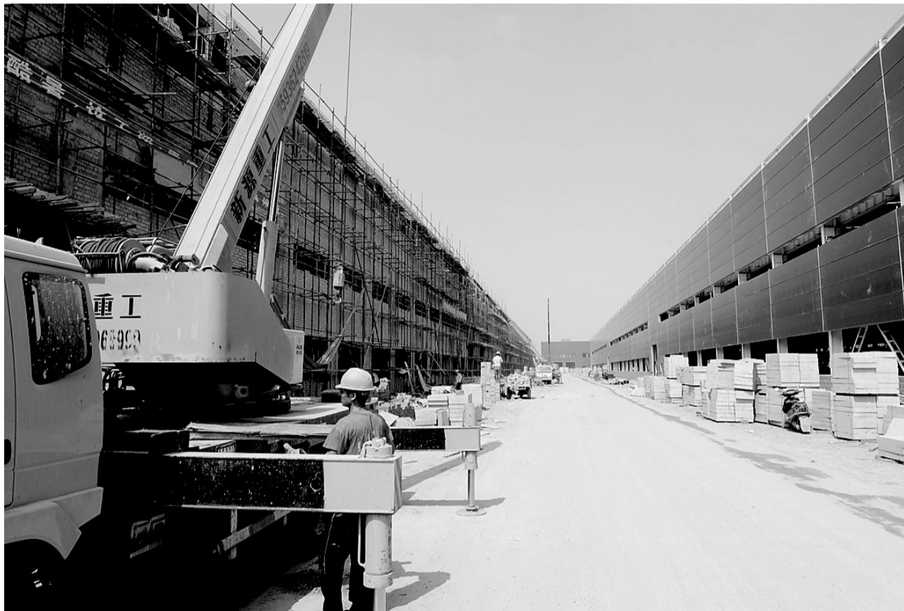
紧张建设中的宇通新能源客车生产基地
