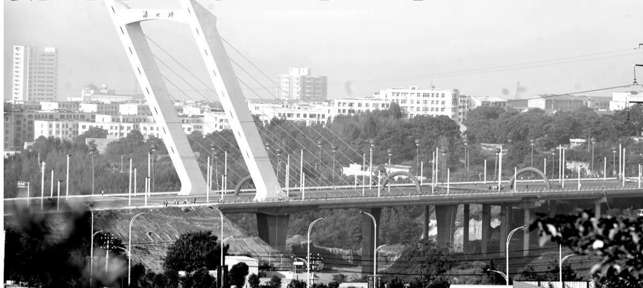
**本报讯** 昨日,具有新密城市标志性建筑的溱水公路大桥——溱水桥建成通车,来自四面八方的市民目睹了大桥的通车盛况。据了解,溱水桥工程是新密市委、市政府确定的重点工程,西起北密新路,东至密州大道,全长1027米。其中主桥跨度227.96米,宽50米,主塔倾角59度,高80米,采取波形钢腹板箱梁、独
