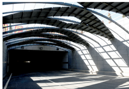
107辅道下穿隧道工程。
