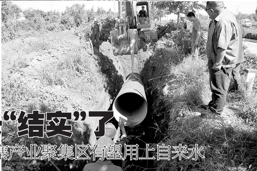
马寨供水工程正在施工中
