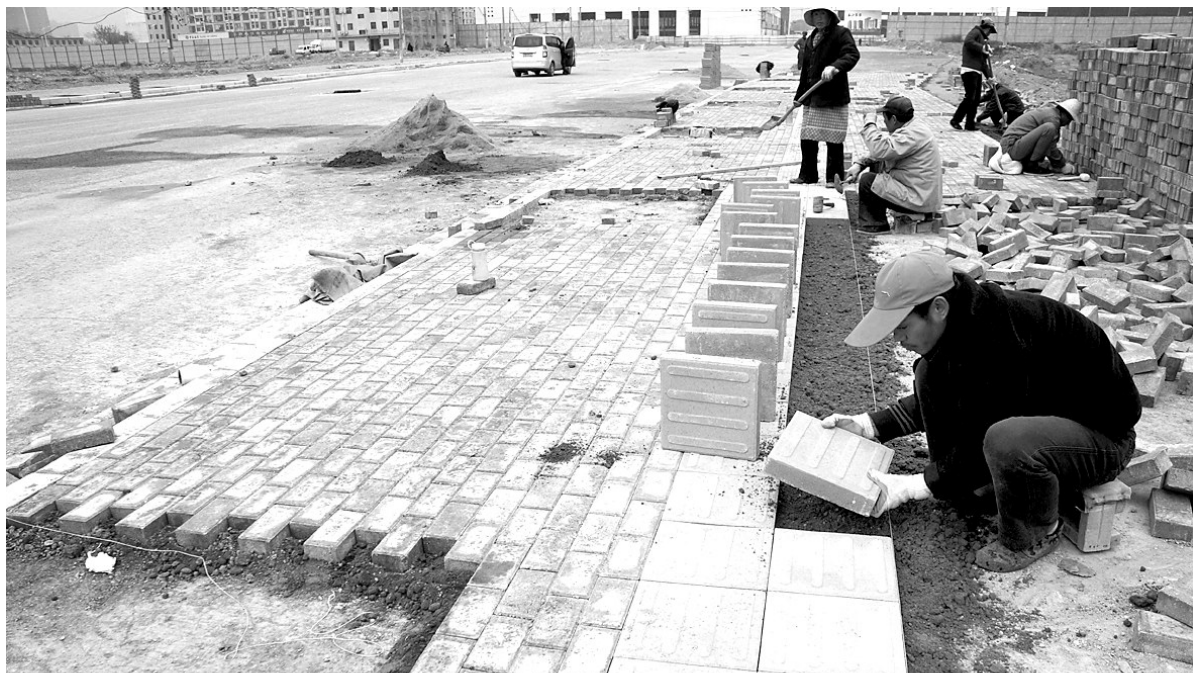
端午路正在铺设人行道道砖,进行工程收尾。
