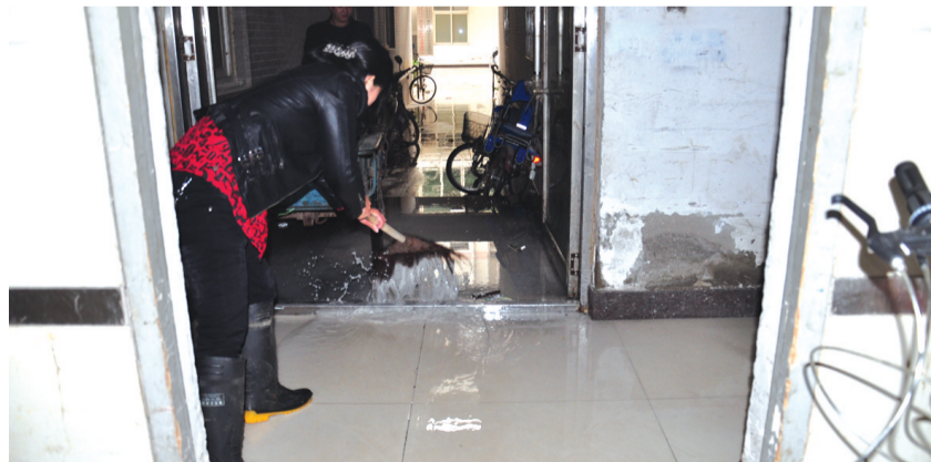
电梯间渗水现场
