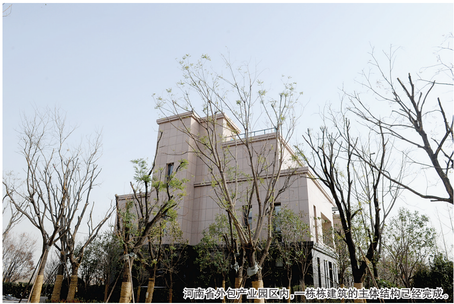
河南省外包产业园区内,一栋栋建筑的主体结构已经完成。
