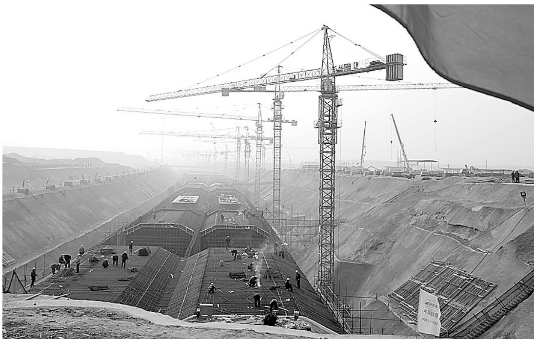
龙源十三街一期和龙翼四街湖底隧道建设如火如荼
