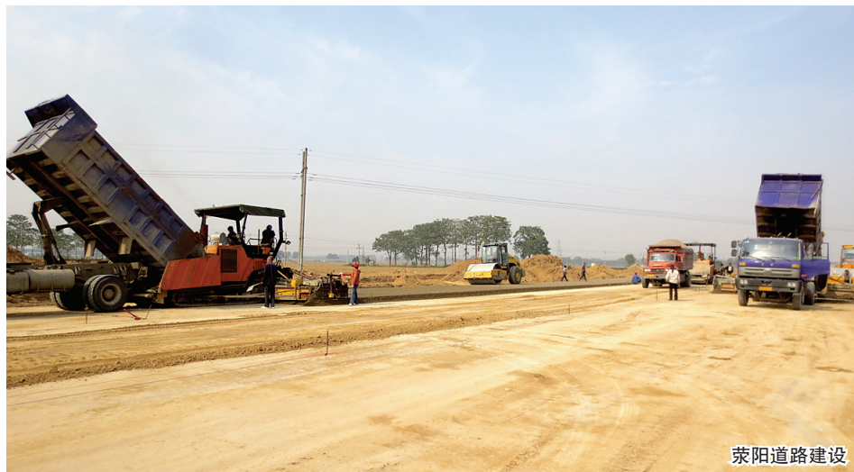
荥阳道路建设
