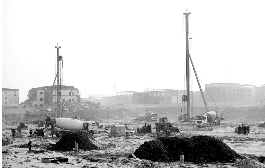
经济技术开发区瑞锦小区正在建设中
