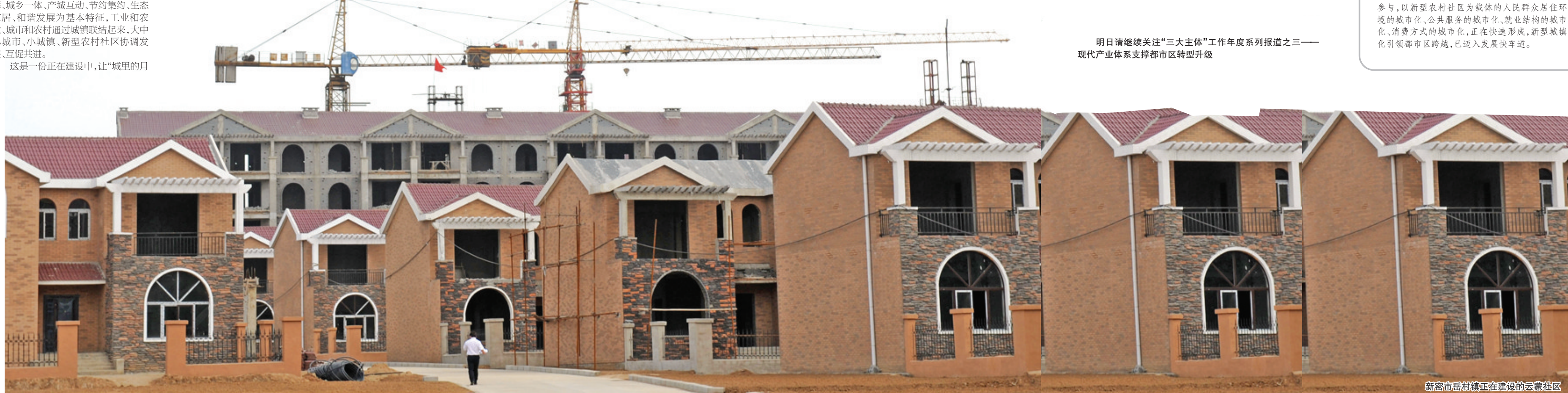
新密市岳村镇正在建设的云蒙社区
