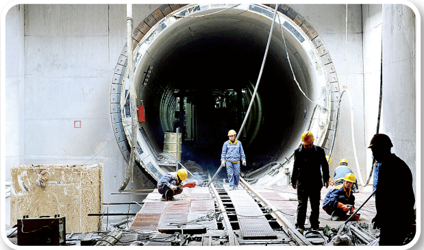
正在建设的地铁2号线工地
