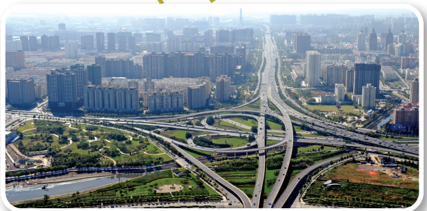
中州大道金水路立交桥
