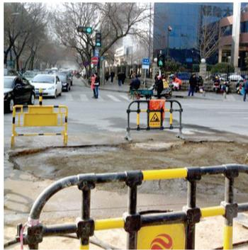
污水管道老化导致泥土流失,22日花园路丰产路口出现路面塌陷,形成一个长3米、宽2米、深3米多的大坑。
