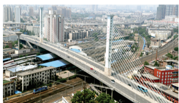
我市大多数立交、高架未整体绿化
