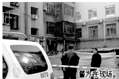
乌黑的外墙,三楼住户的外层窗户连窗框都被震碎。
