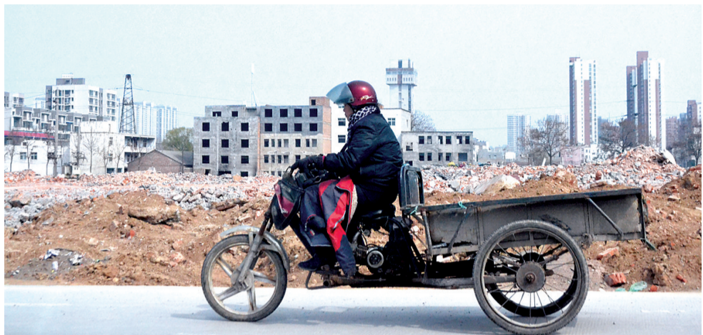
石羊寺村拆迁现场
