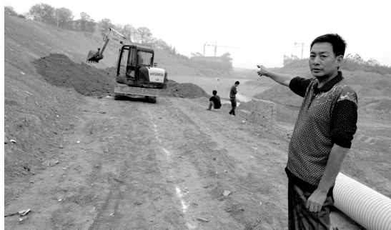
污水治理工程加紧施工
