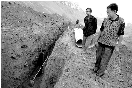
污水治理工程只剩下埋管
