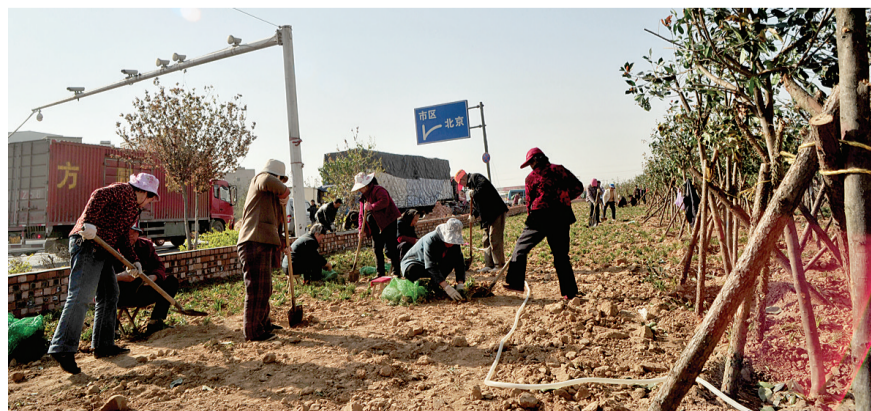
工作人员加紧施工
