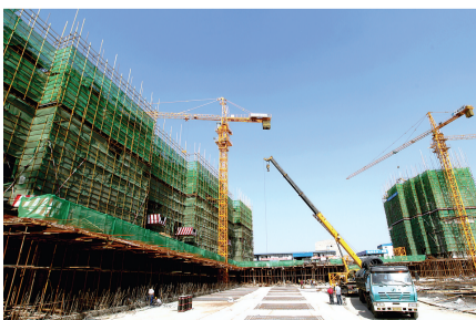
经开区瑞锦安置区1#地块建设现场
