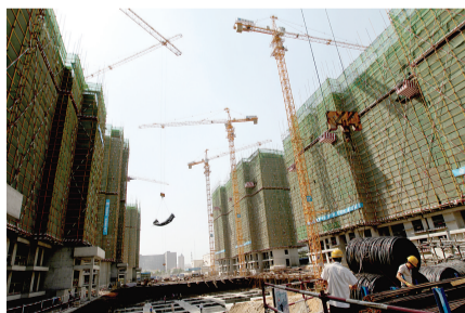
经开区世和安置区建设现场
