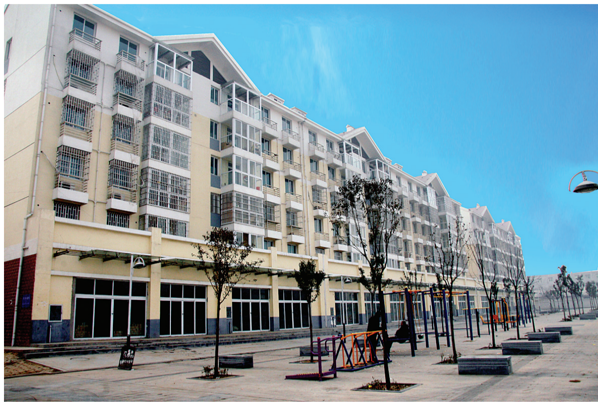
经开区已交付使用的盛和安置区一期工程
