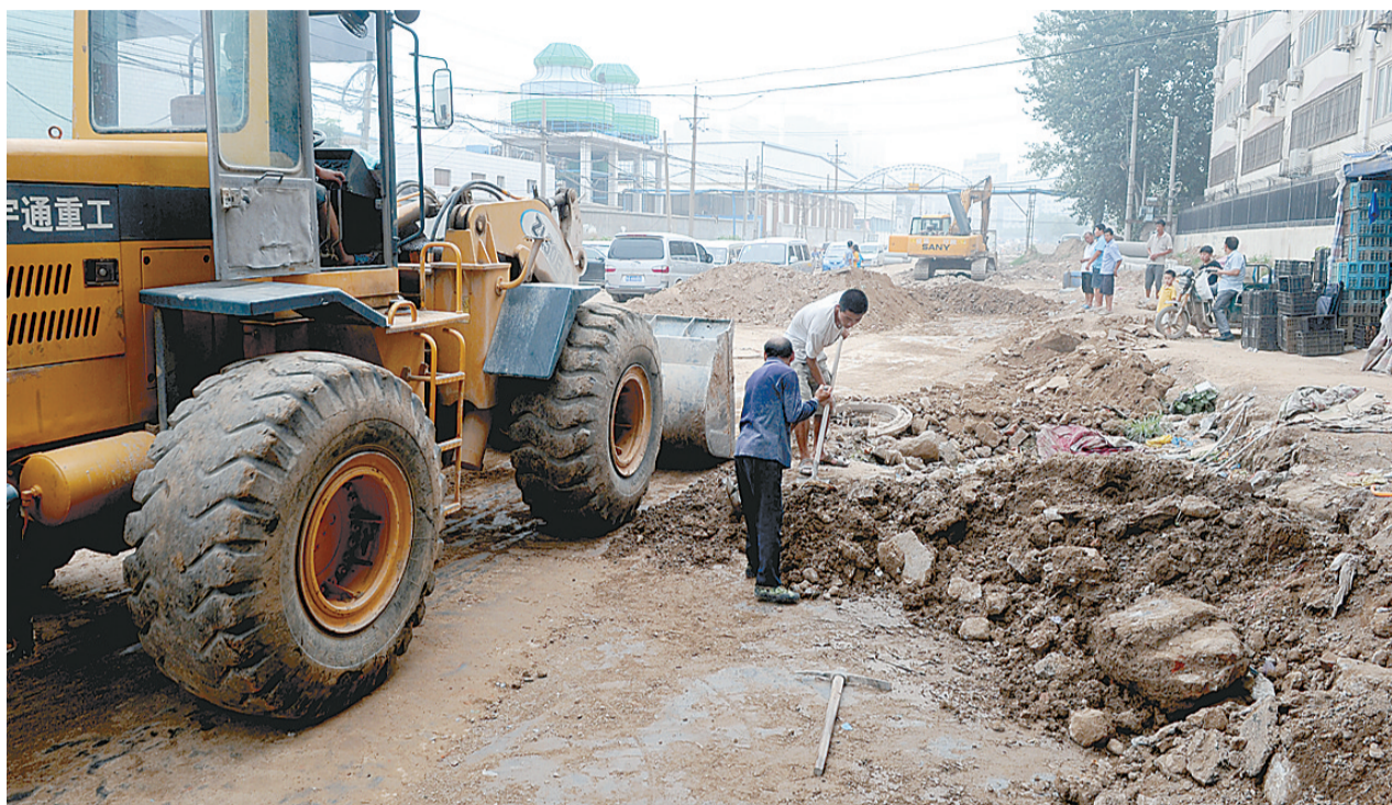
水科路西段,工程车辆正在忙碌。
