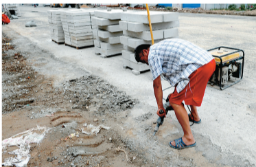
昨日下午,工人正在水科路东段路边施工。
