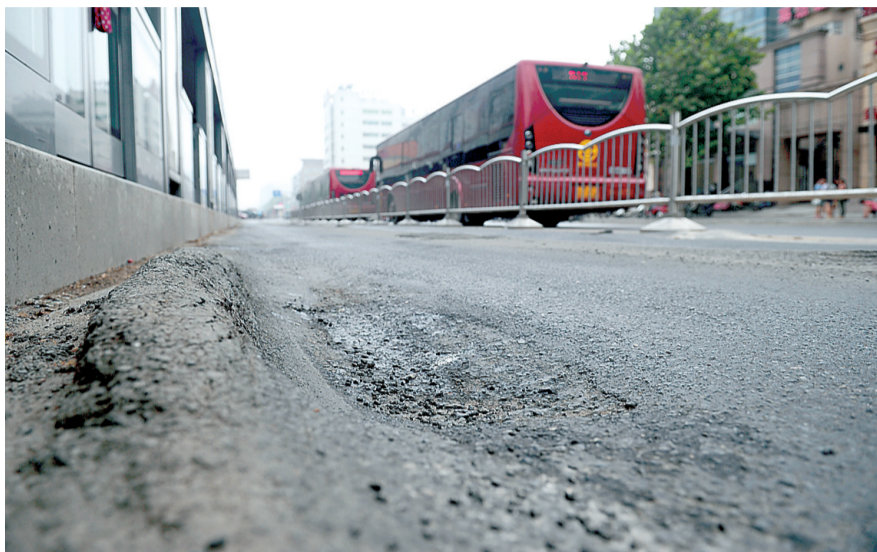
建设路桐柏路BRT公交站台北侧路面“沟壑纵横”,损毁严重。
