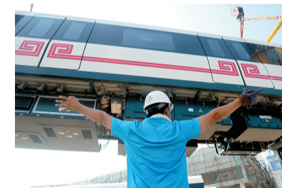
指挥吊车将车厢放到轨道上。
