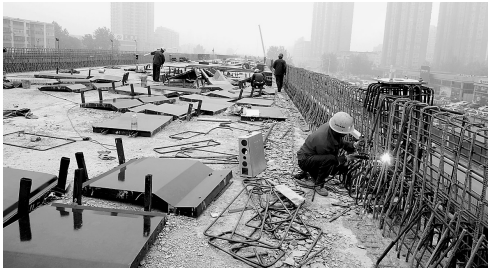
北三环高架部分正在施工中
