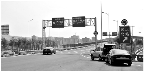
花园路与连霍高速互通式立交新建工程已通车
