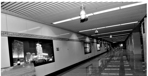
样板站体育中心站已基本完成装修
