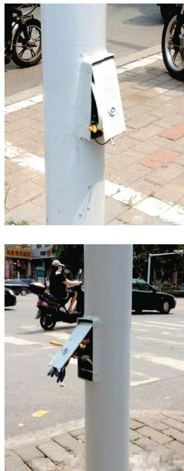
左图:路灯杆底部维修孔盖子打开,线路外露;右图(网友提供):桐柏路洛河路口,两个信号灯灯杆电线外露。
