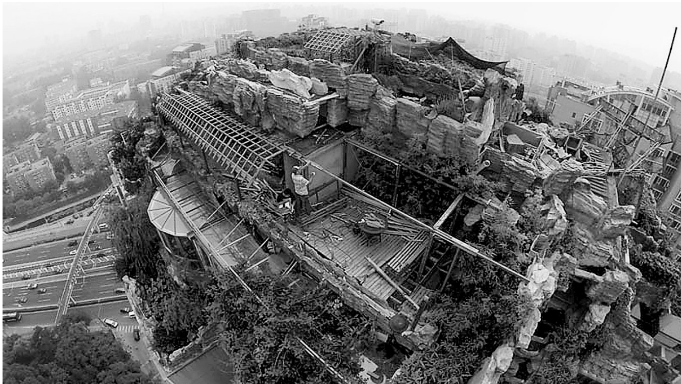
新浪航拍的别墅拆除现场:8月15日,工作人员在拆除人济山庄小区B栋“楼顶别墅”。
