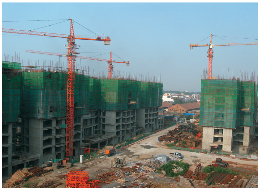
巩义市回郭镇首席产权式高档新型农民社区——龙祥花苑建设项目加快建设。该项目总投资达3亿元,计划工期今年底实现封顶。该工程包括两幢23层、两幢16层、一幢10层,560套房,楼宽距达80米,其23层地标建筑将引领建设小城市未来。 通讯员 祖东平 文/图
