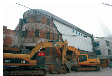
2011年2月,正在拆除的影剧院。
