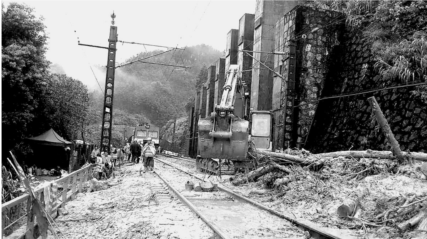
8月18日,在多处反复发生边坡溜塌和泥石流灾害的京广线粤北路段张滩至土岭区间,工作人员在抢修。 新华社发
