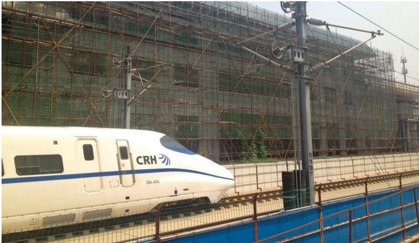
正在建设中的高铁荥阳站
