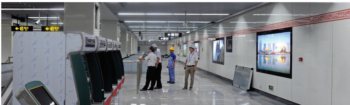
体育中心站装修接近尾声,墙面上的广告已经亮了起来。
