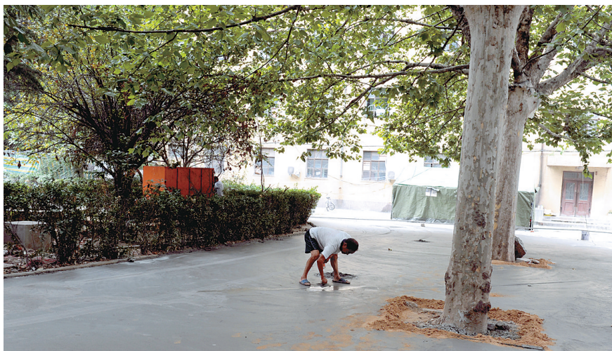
工人在对刚刚硬化过的路面进行修整。 郑州晚报记者 马健 图
