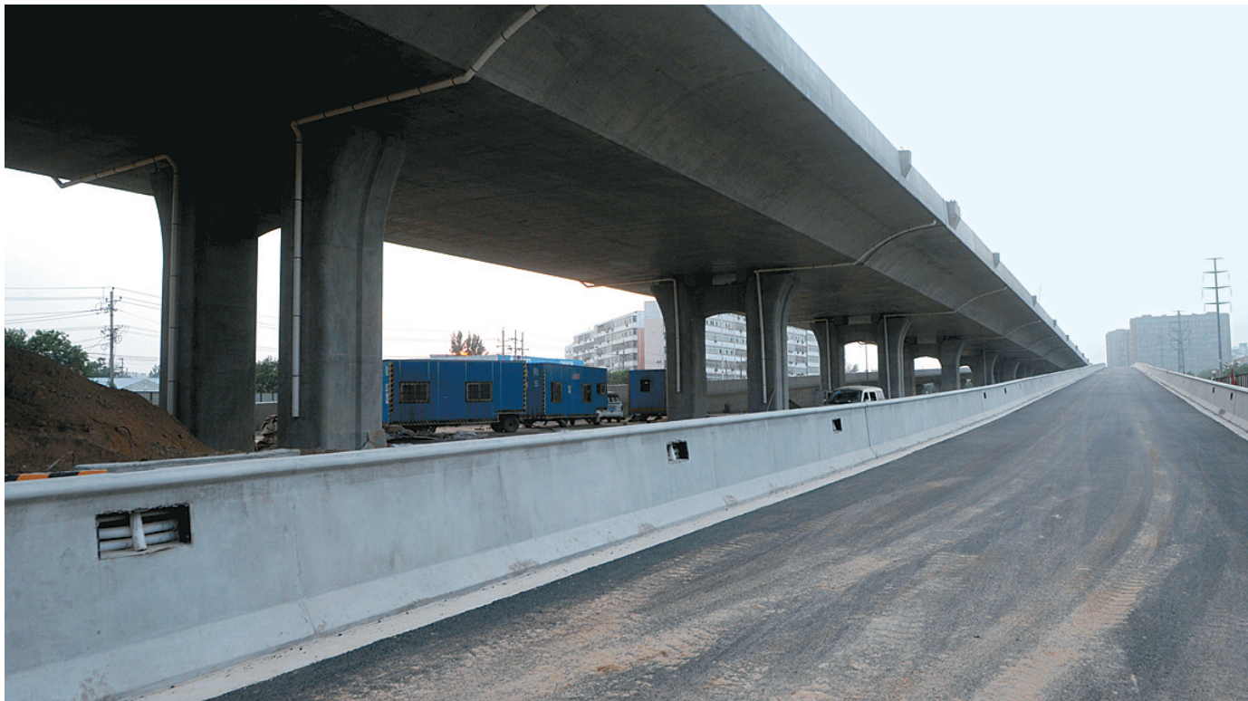
长江路西三环交叉口,西三环快速路高架桥主体已经完工。
