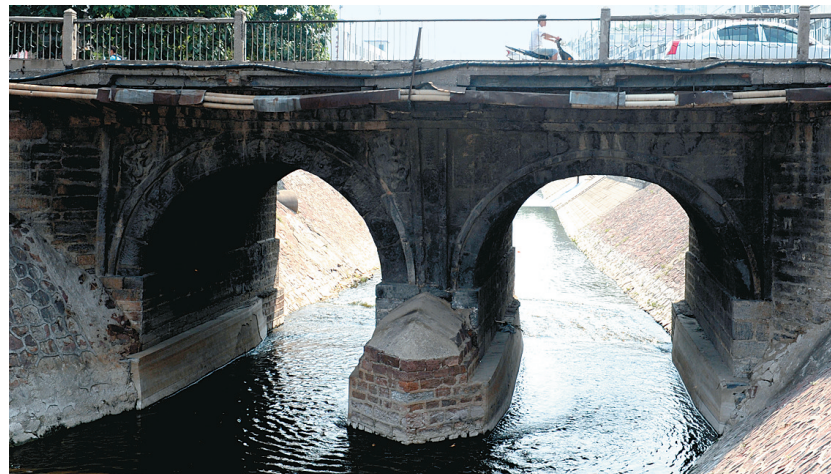
因道路扩建,古桥上方加建了新桥,只有在桥的西侧才能看到古桥风貌。 郑州晚报记者 马健 图
