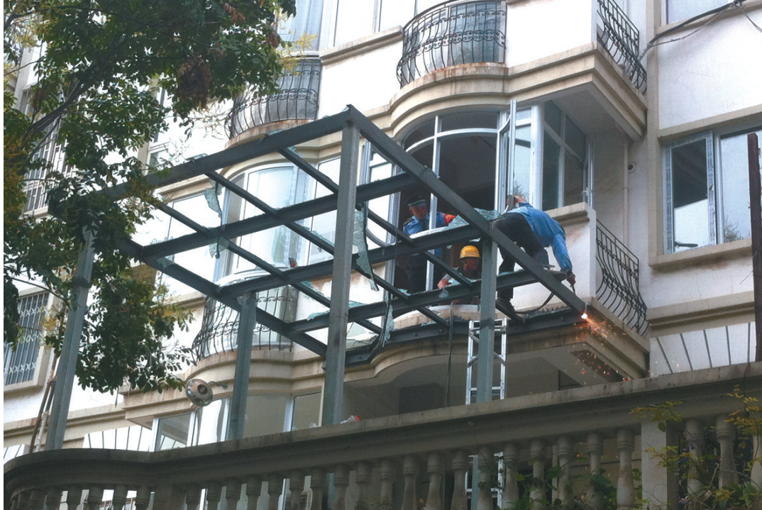
工作人员用氧气焊割将违章搭建予以拆除
