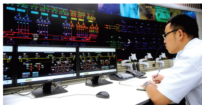
已经建成并投入使用的郑州市轨道交通调度中心。
